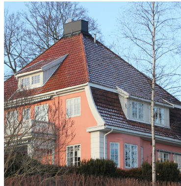
Verdifull historisk villabebyggelse bevares. Bildet viser en villa i Priorveien.
